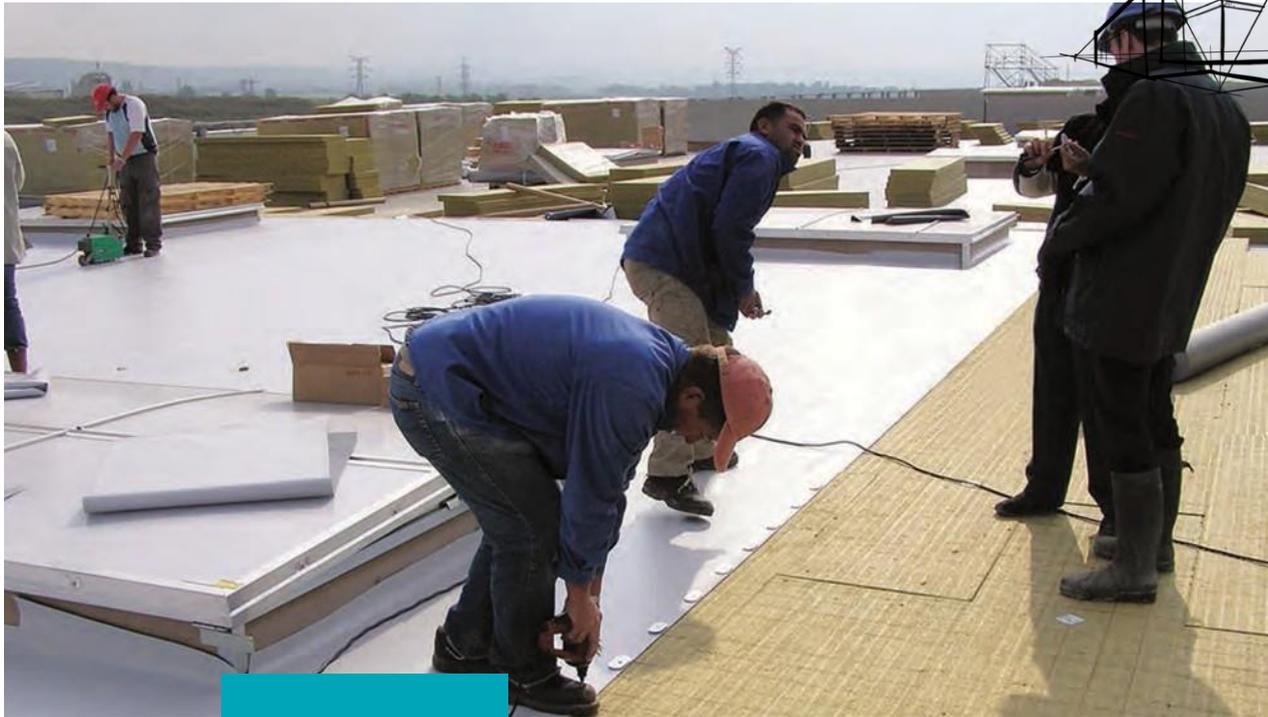
ROCKWOOL TOPROCK® DD es una placa aislante de lana de mineral de roca de alta densidad y sin revestimiento para aplicaciones de techumbre con poca pendiente. TOPROCK® DD es la placa adecuada para cubiertas con poca pendiente y es compatible como sustrato para sistemas de membrana sujetos mecánicamente.
